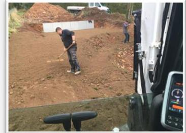
Nous utilisons nos propres machines pour réaliser un trou répondant aux dimensions de la piscine souhaitée, augmentées de 60 centimètres de chaque bord afin de laisser place au drain en gravier. Le coût du terrassement inclut généralement les tranchées menant au point électrique le plus proche.
