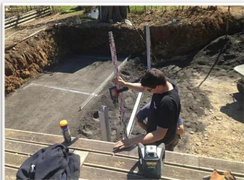
La chape est indispensable à la stabilité de la piscine. En fonction des modèles, nous opterons pour une chape en stabilisé ou en béton. Dans les cas de sols meubles, nous armerons la chape afin de garantir la rigidité de l'ensemble de la structure.
