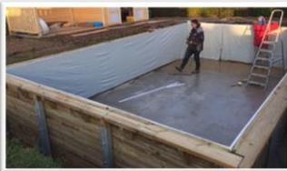
Un feutre en textile est posé le long des parois afin d'éliminer les légères différences de niveaux entre les bois et la structure métallique. Il s'agit de la première étape d'une pose optimale du liner.
