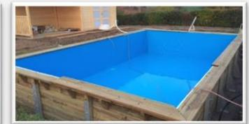
La pose du liner est une tâche très délicate car aucun pli ne doit subsister. Un de nos techniciens doit être en alerte pendant le remplissage des 30 premiers centimètres. Il doit également être particulièrement attentif sur les 30 derniers centimètres.
